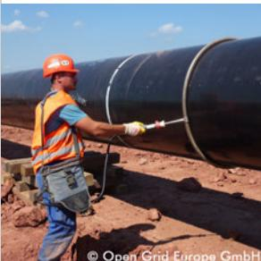
**ISOTEST® Test kit: Pipeline incl. ISOTEST® 4S plus**
